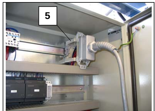
Afb. 54 Vangproefbesturing insteken
